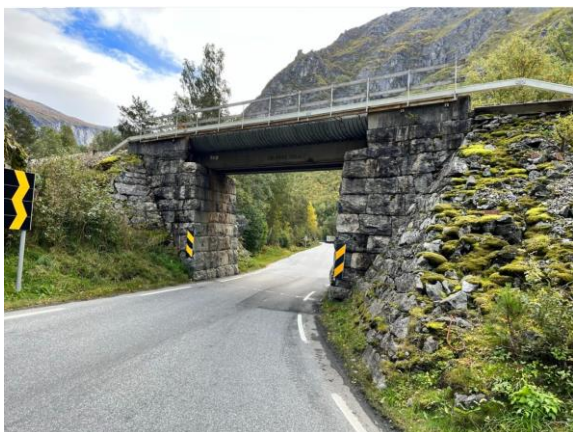
Figur 3-1 Jernbaneundergang ved Skirimoen. Kilde: AAV.
