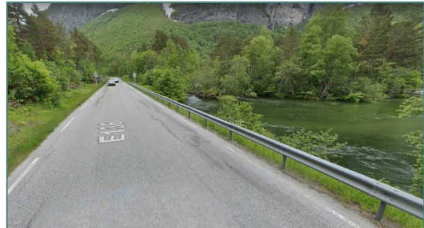
Figur 10-12 Vei på fylling fra jernbaneundergang sett mot øst. Dette er del av gammel vegkropp som anbefales fjernet og restaurert til natur for tema naturmangfold. Kilde: Google Street-view
