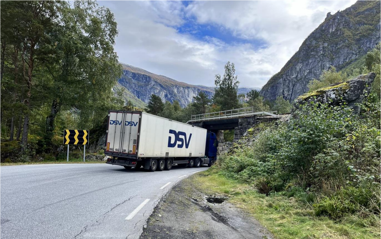
Figur 1-1 Jernbaneundergangen ved Flatmark - Kilde: AAV/Grindaker
