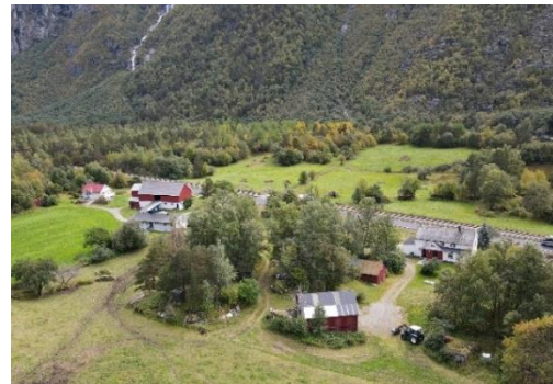
Figur 10-4 Bildet viser gårdsmiljøet og kontakten på tvers av veien. Foto: Grindaker
