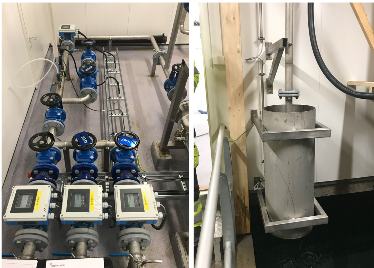
Figur 20: Vann fra 3 brønner og luftekolonne for pH heving
