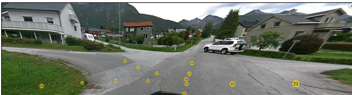
Figur 26 Kryssområde Rønningsvegen, Ørjavegen, Harbakken, Brauta. 5 veger møtes og stort kryssområde (foto: Vegbilder 2019, Rauma kommune)
