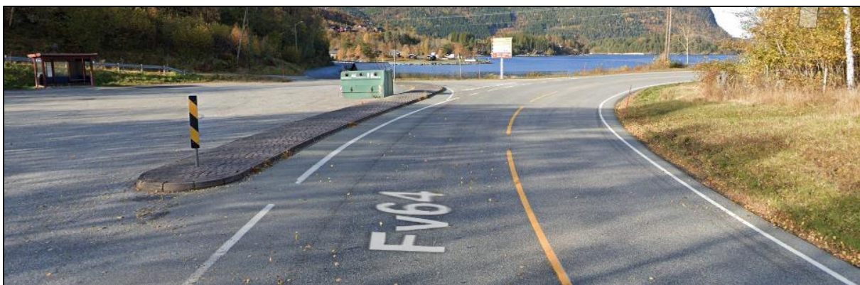
Figur 22 Fv. 64 ved Lerheimskiftet, dårlig sikt for venstresving av mot fv. 6004 Norvikvegen (foto: Google Street View)
