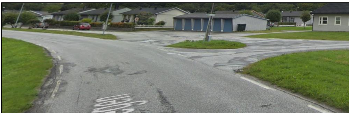
Figur 21 Fv. 5992 Gryttenvegen, stort kryssareal og brei utkjøring fra garasjer/kv. Frydenlund (foto: Google Street View)
