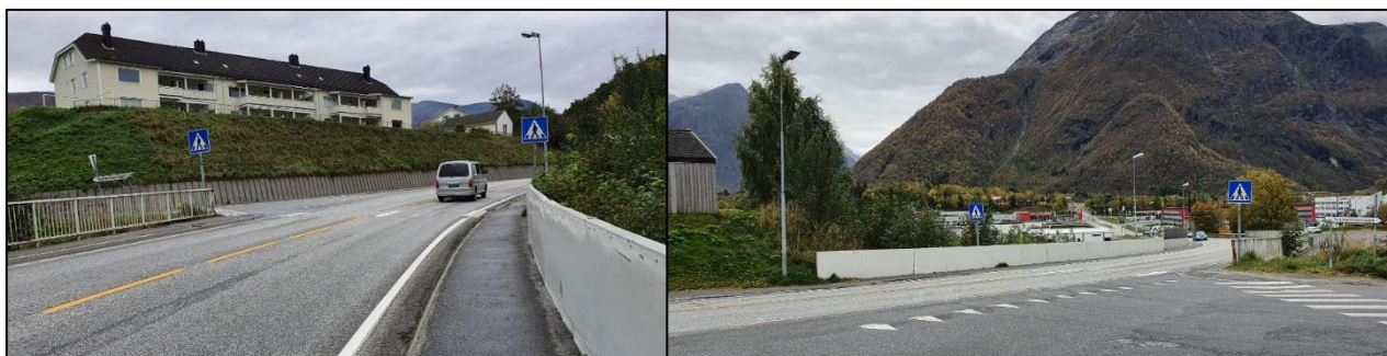
Figur 9 Fv. 64, eksempel på gangfelt med dårlig sikt og dårlig landingsplass (foto: Norconsult)
