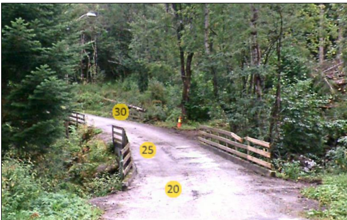
Figur 27 Slemmåbrua. Behov for breddeutvidelse, rekkverk og vegbelysning? (foto: Vegbilder 2019, Rauma kommune)
