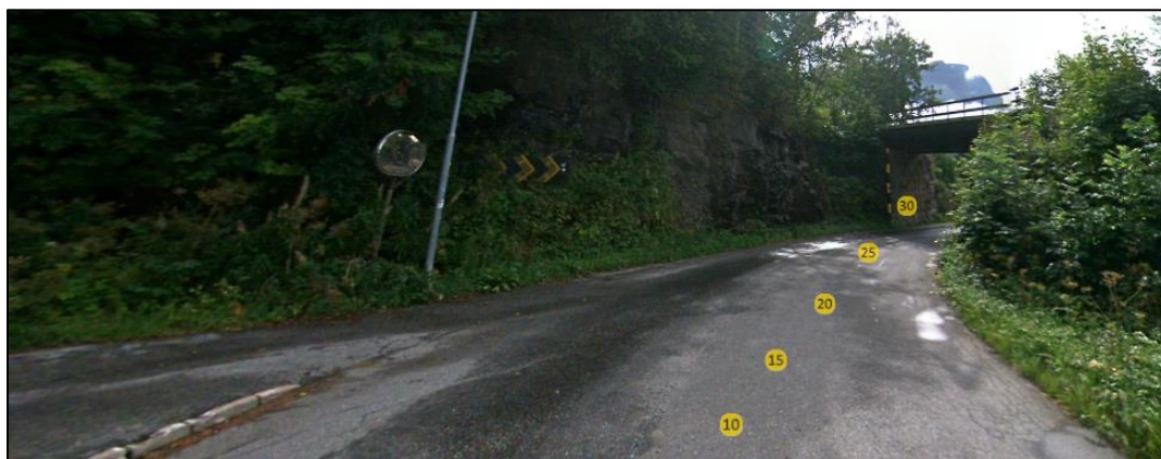
Figur 16 Gamle Romsdalsvegen, et punkt med behov for siktryddingsrutiner (foto: Vegbilder 2019, Rauma kommune)
